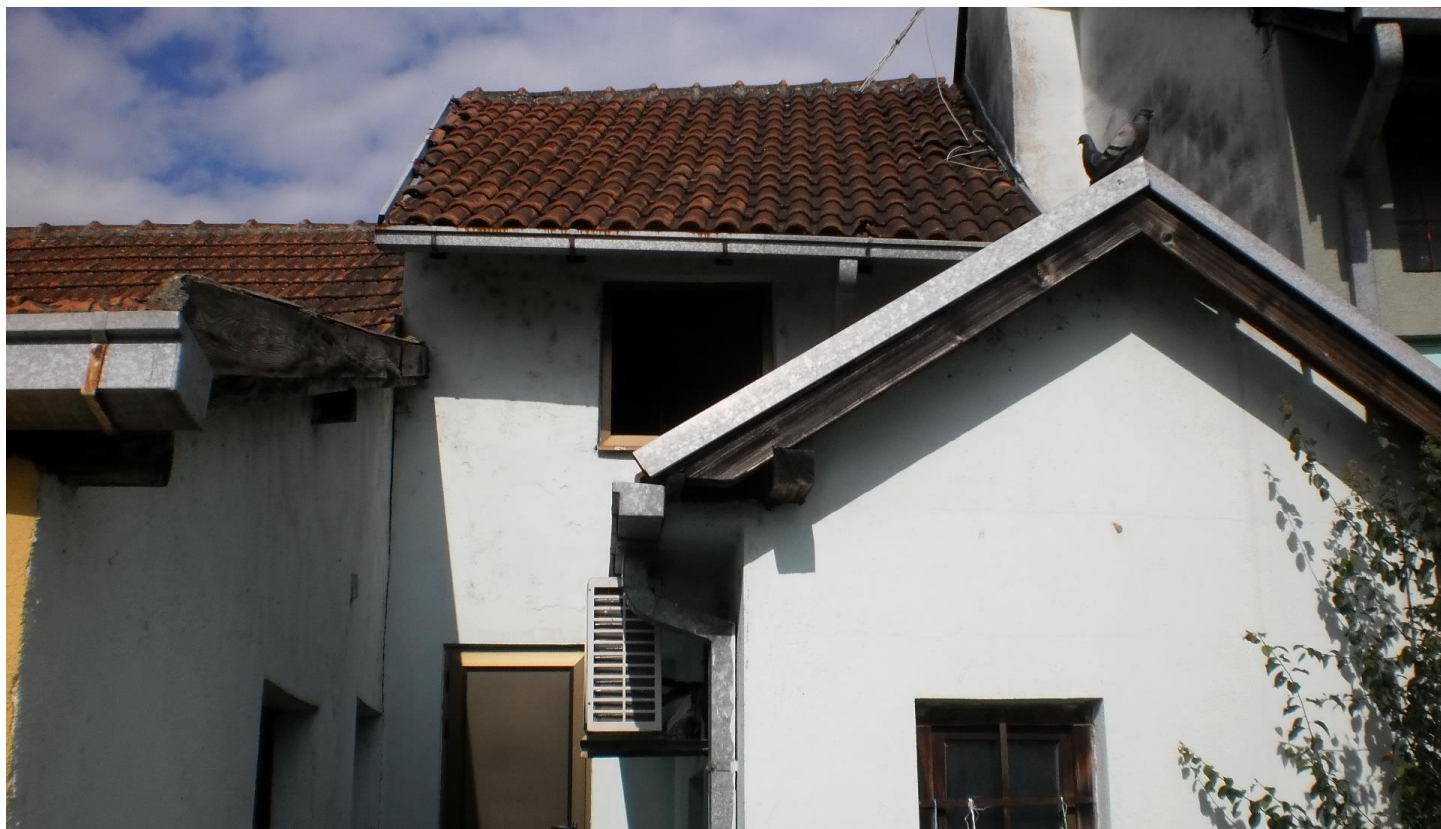
ZAPADNA FASADA – POSTOJEĆE STANJE
