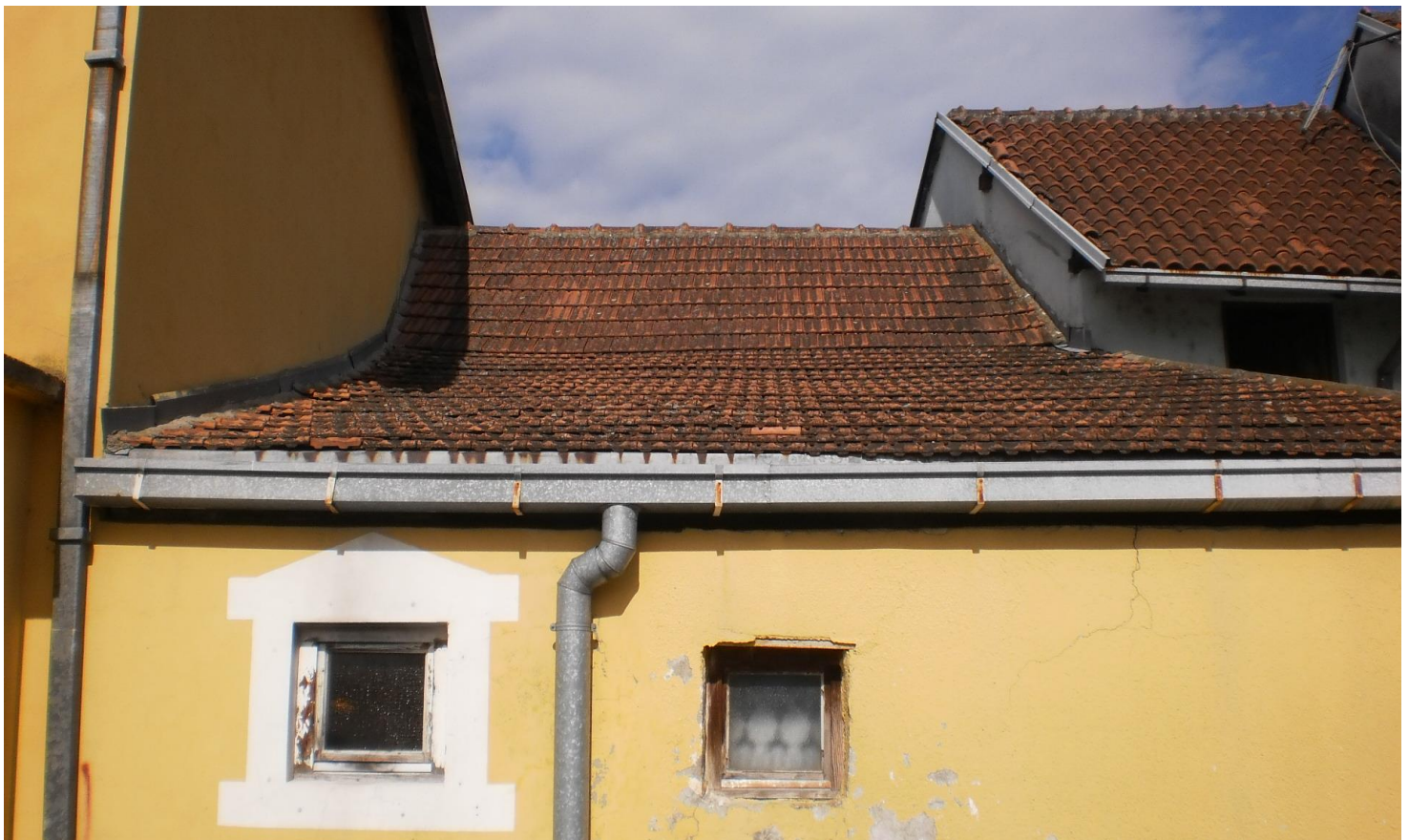
ZAPADNA FASADA – POSTOJEĆE STANJE
